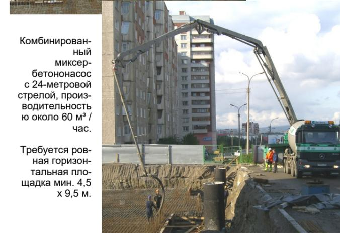
Комбинированный миксер-бетононасос с 24-метровой стрелой, производительность ю около 60 м<sup>3</sup>/час.
