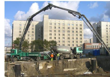
Бетононасос с 36-метровой стрелой, производительностью около 120 м<sup>3</sup>/час.
